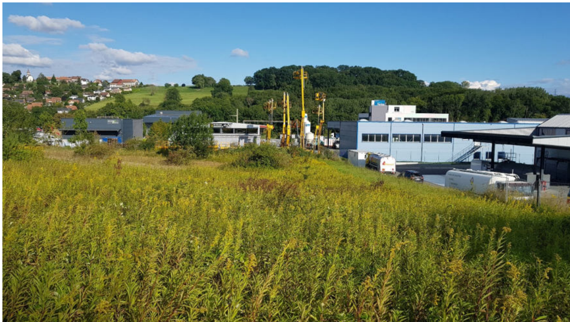
Fig. 9. Nouvelles constructions de hangars en 2021 au sud de la friche de compensation. L. Maumary.
